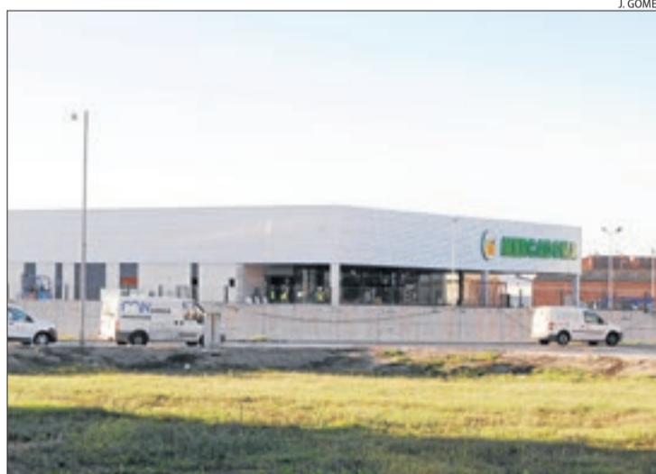
Les obres de construcció del nou Mercadona.
